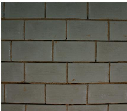
4. Läuferverband der Ziegel für eine Wandstärke von 25 cm. Auflage- und Kontaktfugen werden immer mit einer Mörtelschicht von 10 mm versehen.
