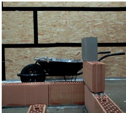
2. Der Mauerfuß sollte aus gebrannten Ziegeln bestehen. Dies schützt die Wand vor aufsteigender Feuchtigkeit.
