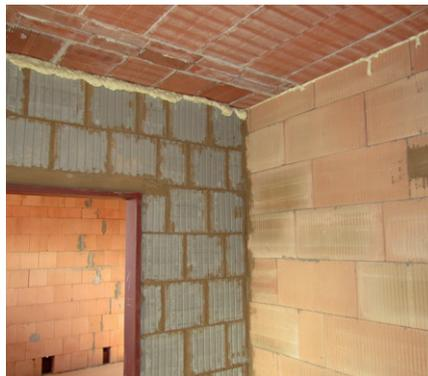
5. Mauerwerke aus ungebrannten Ziegeln können in einem Ziegelhaus als Trennwand verwendet werden.
