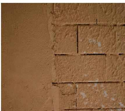
7. Das Mauerwerk wird mit Lehmputzen verputzt. Begonnen wird mit dem Sprühen, danach wird der Grobputz aufgetragen.
